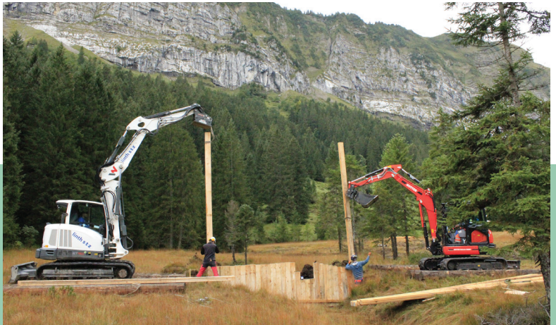
Fig. 3: Travaux de renaturation au Gross Moos à Glaris. Les fonds utilisés pour les travaux de construction sont principalement réinjectés dans l'économie régionale [photo: Lena Gubler].
